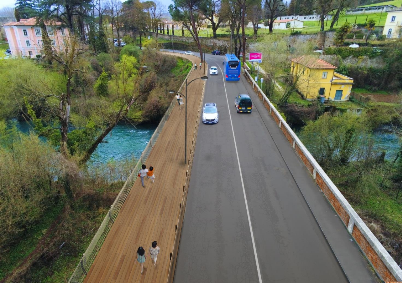
Vista aerea della nuova passerella ciclopedonale
