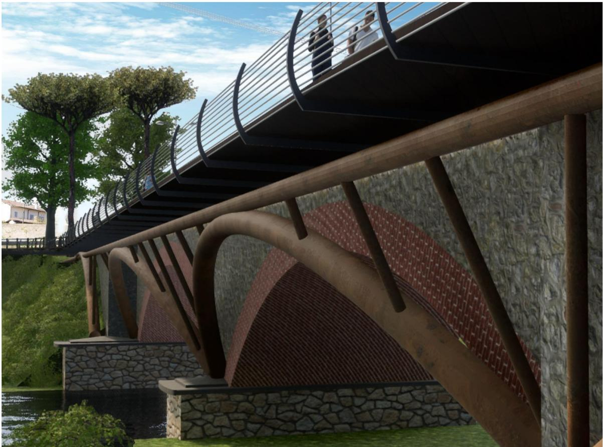
A lato dei rilevati di accesso al ponte la passerella ciclopedonale corre su archi contenuti nel piano verticale anziché in un piano inclinato di 22°, come i 2 archi frontistanti le arcate che scavalcano il fiume Velino.
